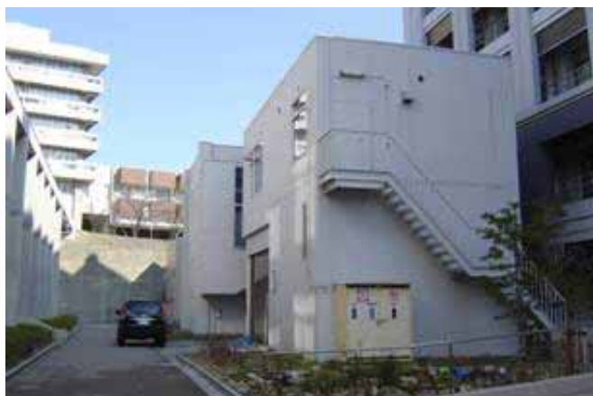
環境管理センターの外観
