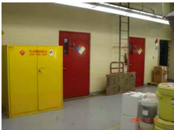
建屋内部：各廃液の保管室の扉が見えている
