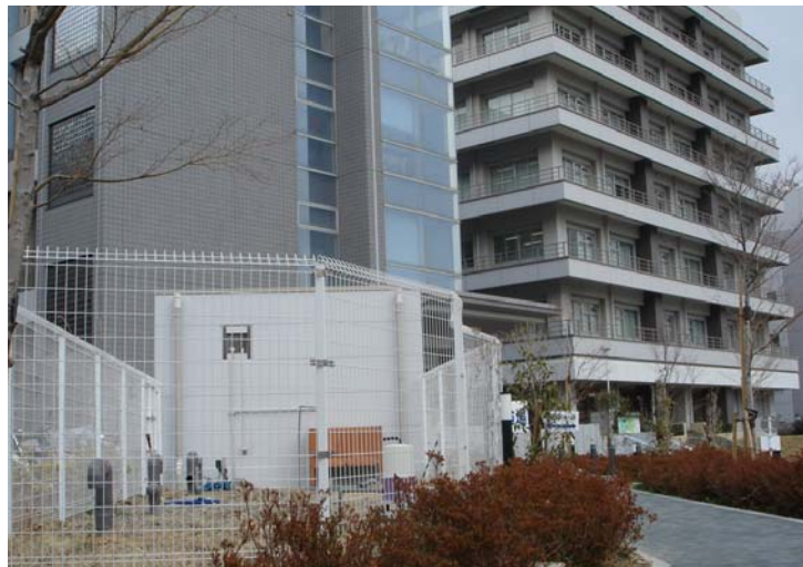
神戸大学自然科学系中和曝気(ばっき)槽周辺風景 手前:曝気槽、左後:ベンチャービジネスラボラトリー棟、右後:自然科学1号棟
