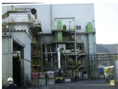
図 2. 疑似感染性廃棄物用エレベータ（右の緑部） （左上部がロータリーキルン炉）
