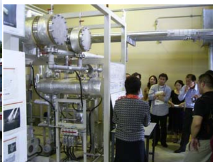
バイオエタノール製造ライン
