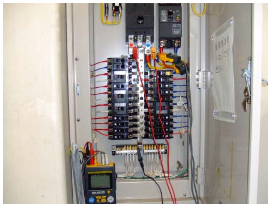
写真1 電力消費量の測定状況
