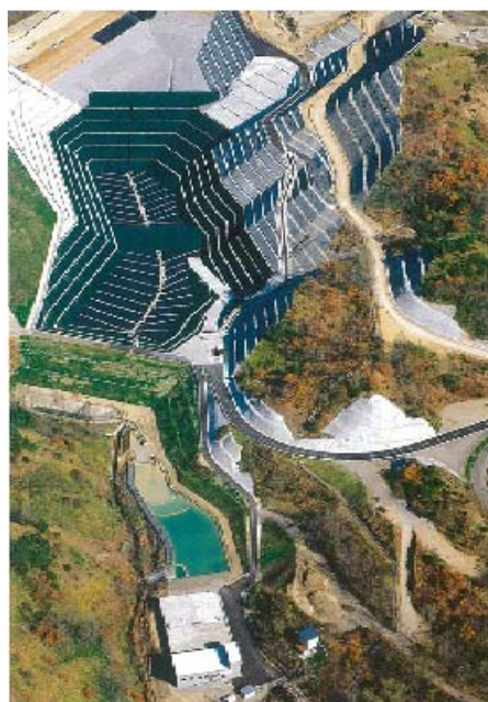
写真2. 管理型最終処分場
