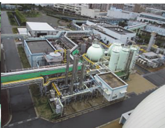
写真2. バイオガス精製設備
