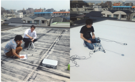
図1 屋根面の反射率の測定状況 (左:改修前, 右:改修後)
