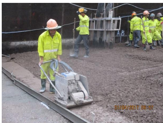
(3) プレート転圧機による RCC の転圧
