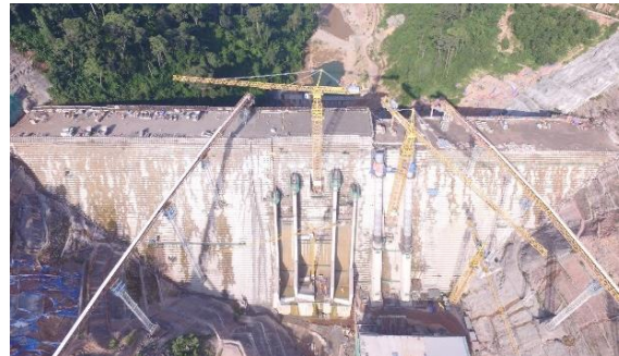
(16) RCC ダム施工全景
