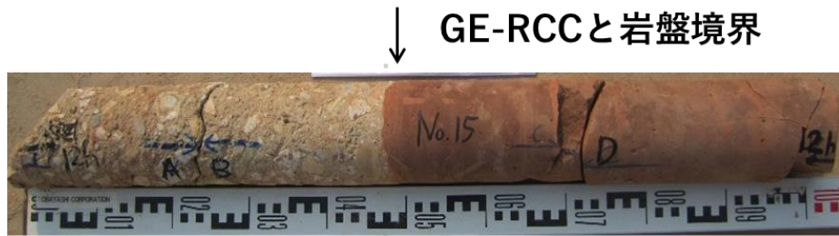
図 7-19 コア（GE-RCC と岩盤）の状態
