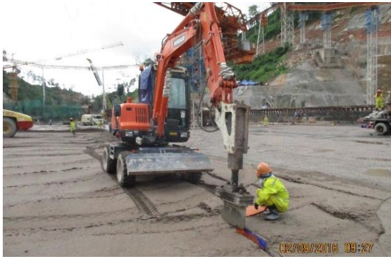
(13) 横継目処理 (PVC シート挿入)
