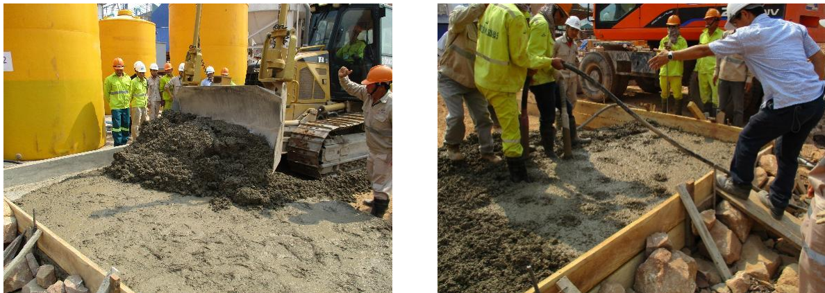
(1) ブルドーザによる敷均し
