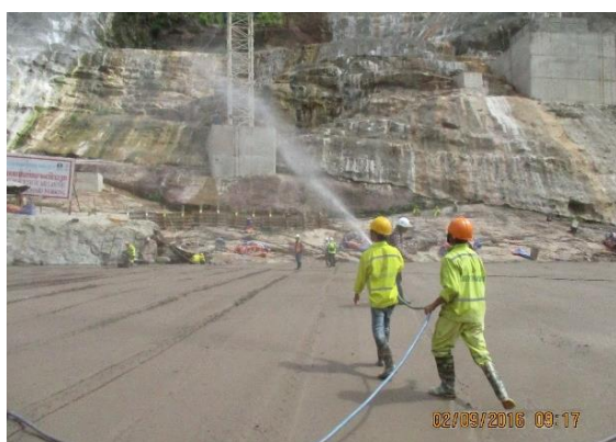
(1) ホースによる散水養生
