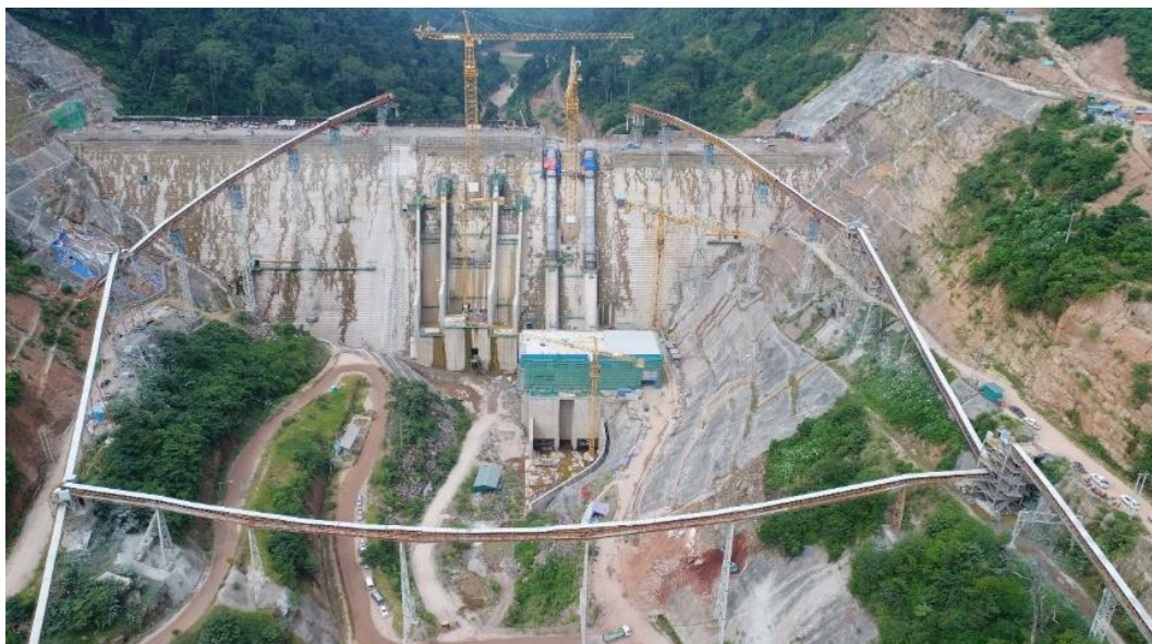
図 6-18 RCC 運搬用のベルトコンベア
