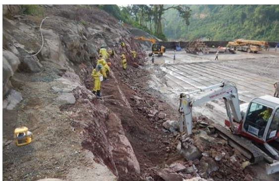
(1) ダム基礎岩盤の仕上げ掘削
