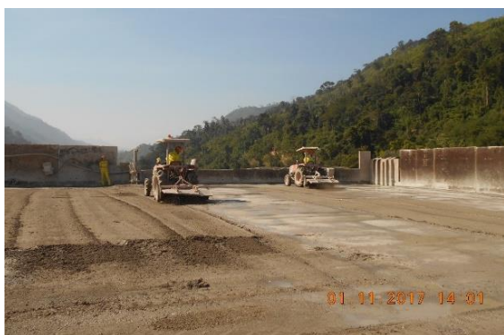
(3) 打継目処理（グリーンカット）
