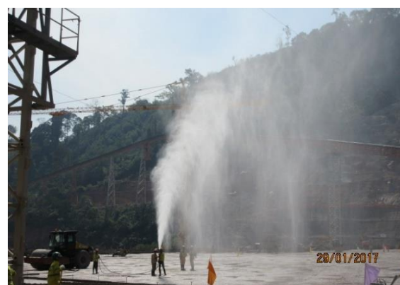
(2) 噴霧散水装置による散水養生
