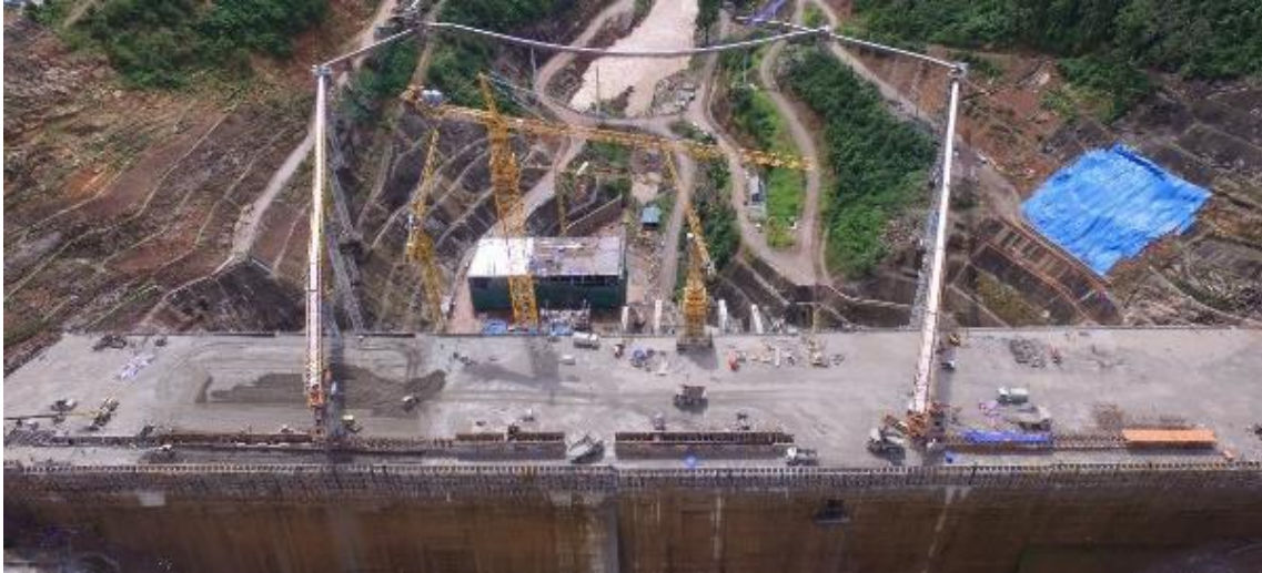
図 6-1 RCC ダムの施工状況（上流から望む）
