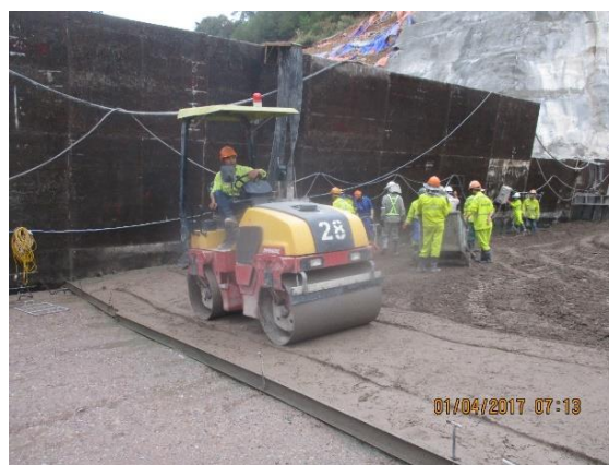
(4) 転圧ローラによる RCC の転圧
