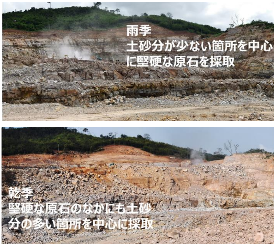
図 6-15 雨季と乾季の原石山採取の分別状況
