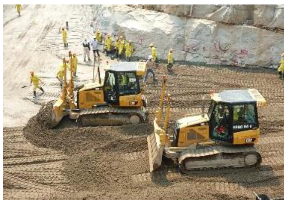
(3) ブルドーザによる RCC の敷均し
