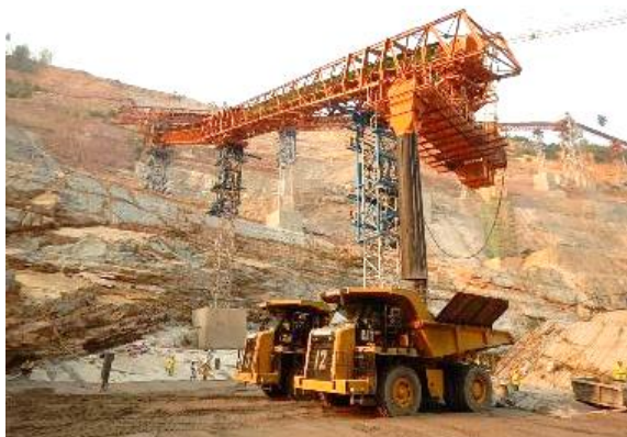
(1) ベルトコンベアによる RCC 運搬・ダンプトラックへの RCC 投下
