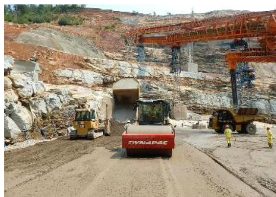
(4) 振動ローラによる RCC の転圧
