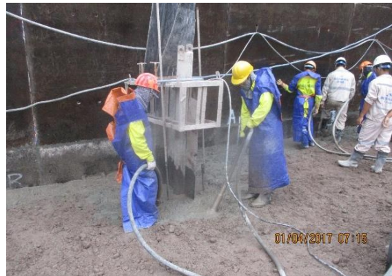
(12) GE-RCC 締固め
