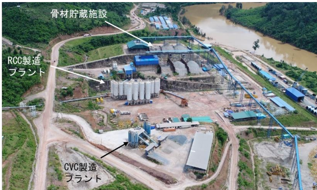
図 6-16 骨材貯蔵施設および RCC 製造プラント
