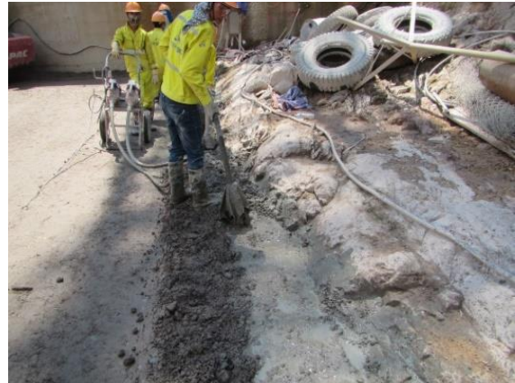
(4) GE-RCC 締固め
