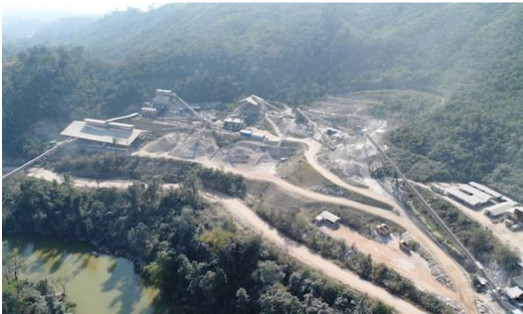
図 6-13 骨材製造プラント
