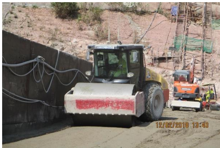
(4) RCC と GE-RCC の境界部の振動ローラによる転圧
