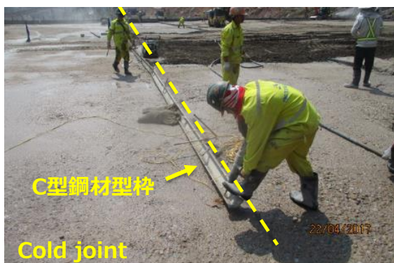
(1) C 型鋼材型枠の設置
