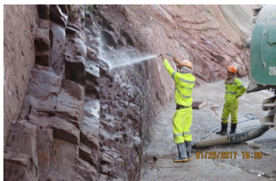
(2) ダム基礎岩盤の清掃
