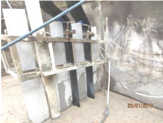
(1) PVC 止水板と鋼製板
