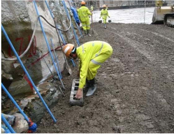
(1) 鋼棒により穿孔
