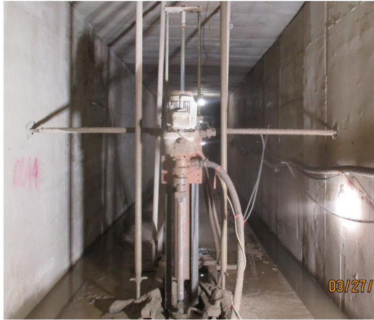
図 6-11 改善後の削孔機械の固定方法
