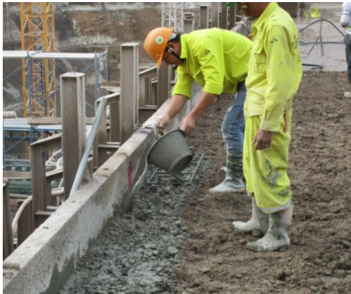
(2) フレーム設置によるグラウト材の 注入量を管理
