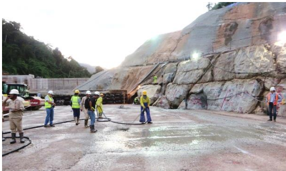
(7) 打継目処理 (グラウト材塗布)
