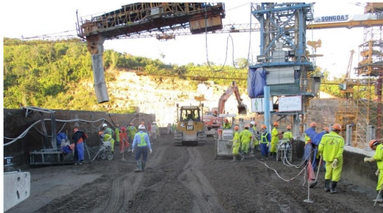
図 6-21 RCC 敷均し時の作業エリア区分け
