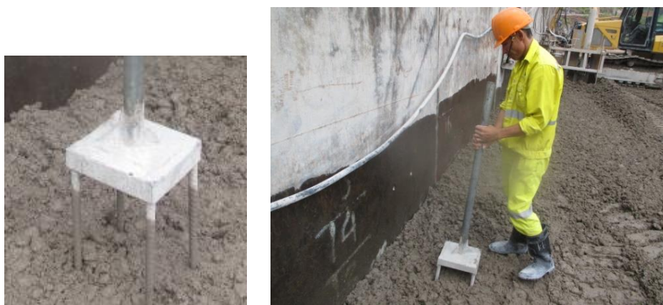
(1) 専用穿孔器具による穿孔長・穿孔間隔管理
