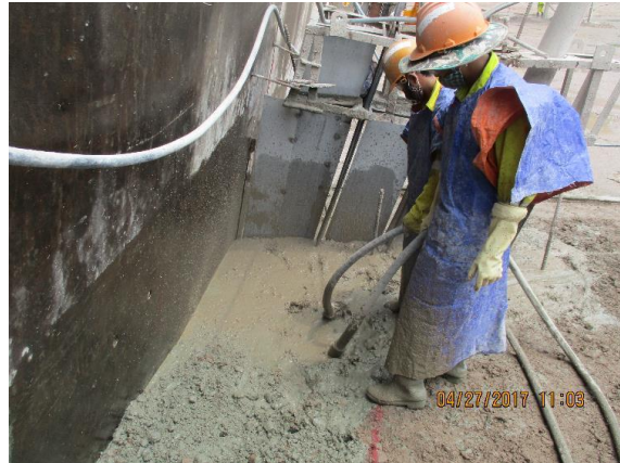
(3) 2人での GE-RCC の締固め
