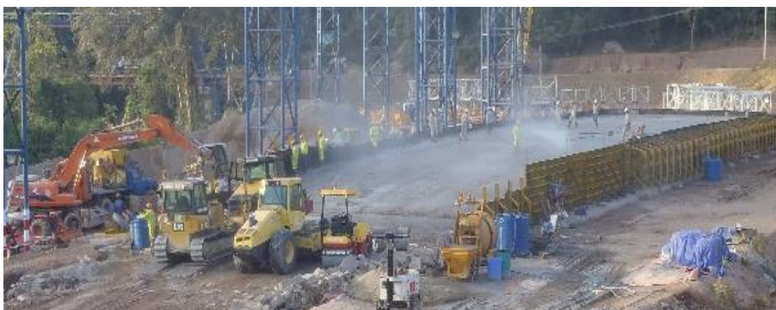
図 6-2 第 1 回試験施工の状況
