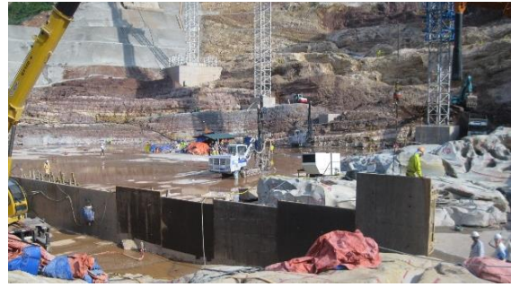
(6) 型枠設置・脱型
