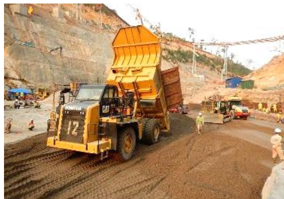
(2) ダンプトラックによる RCC の運搬・荷卸し
