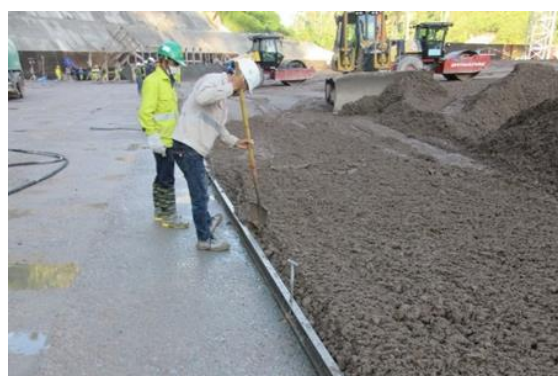
(2) RCC の敷均し
