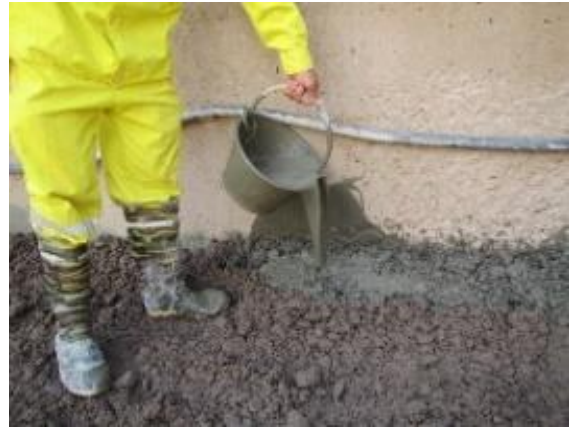
(2) グラウト材を注入
