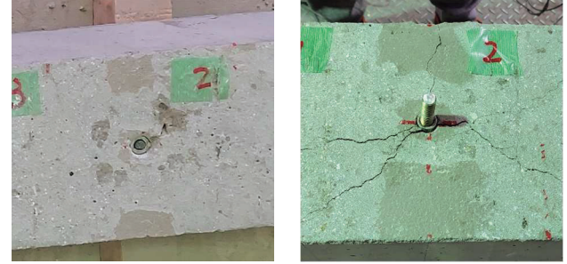
(c) 拡底 45 No.2 (鋼材破断) (d) 拡張 45 No.2 (割裂破壊)
