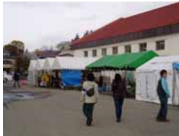
左：体育館正面 右：体育館側面
