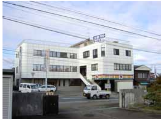
図3 事務所併用住宅の3階住宅部分 （十日町春日町1丁目、事例No.9）
