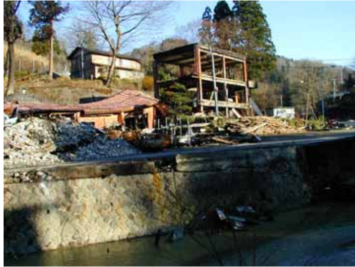
図7 全焼した集落センターほか（事例No.4）
