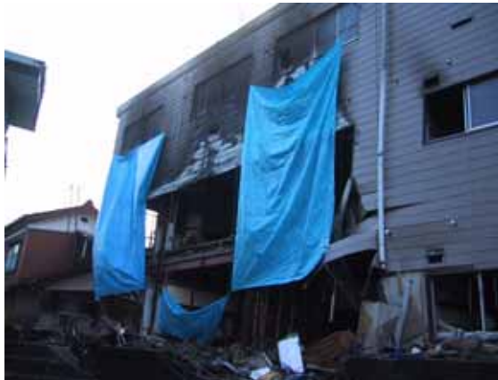
図9 出火した共同住宅（S造3階建、事例No.5）
