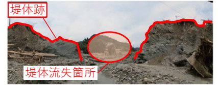
出典：泉 明良ら：平成29年7月九州北部豪雨におけるため池の被災要因 ▲溜池の決壊
