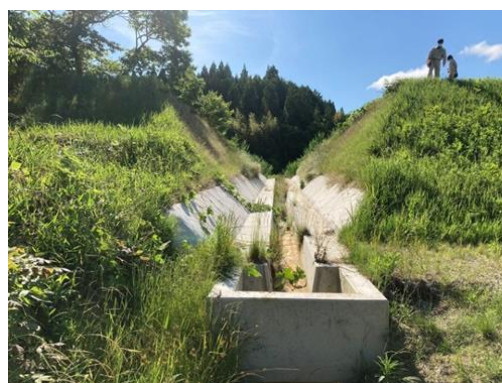
堤体をV字に切って廃止したため池 (2022年現地調査)
