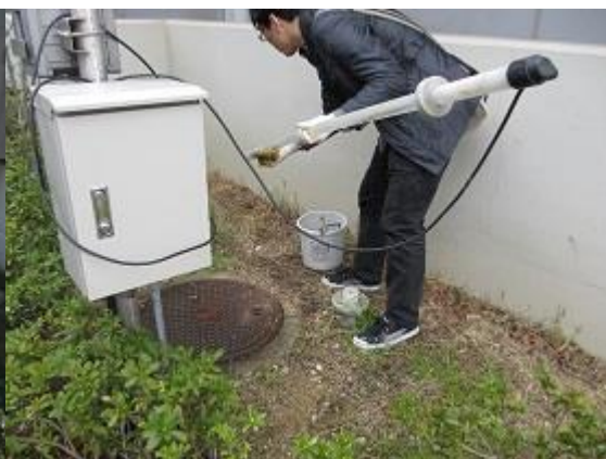
図 2 pH 電極メンテナンスの様子 センサー部分の洗浄
