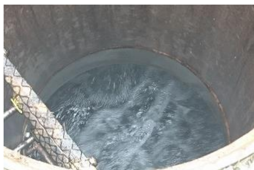
曝気槽内部の様子
