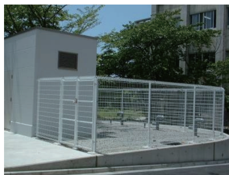
中和・曝気槽
