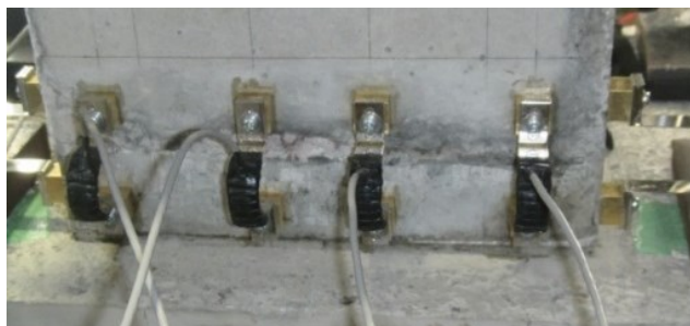
写真 3-8 \pi 型変位計によるひび割れ幅の測定
