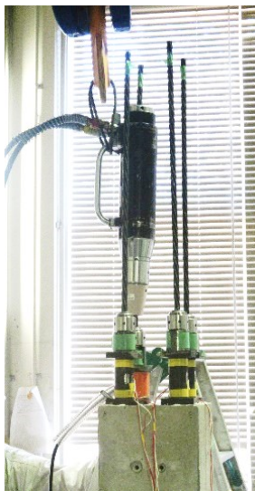
写真 3-5 ジャッキによる PC 力導入
