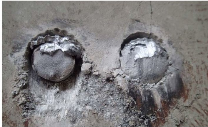
写真 6.6 スタッドの破断面 (試験体 No. 8)
