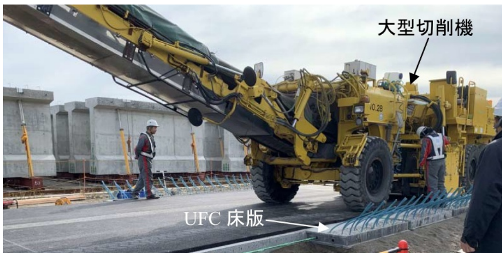
写真 7.3 大型切削機による切削試験状況
