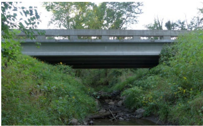
写真 1.4 米国 FHWA における UHPC 床版 (Little Cedar Creek 橋)
