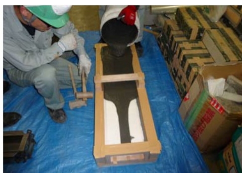
(a) UFC の打設
