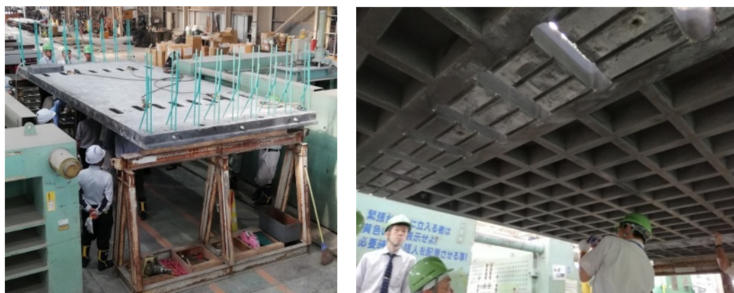
写真 7.7 製作工場での UFC 床版の仮置き状況
