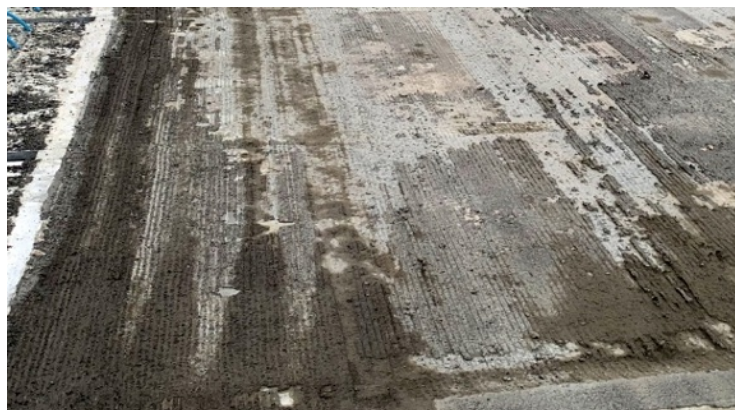
写真 7.5 切削試験後の UFC 床版の状況（全景）
