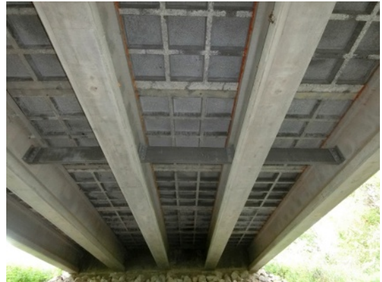
写真 1.4 米国 FHWA における UHPC 床版 (Little Cedar Creek 橋)
