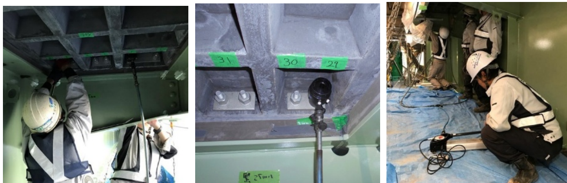
写真 7.2 床版同士の接合部の緊張状況（阪神高速道路 信濃橋入路橋）
