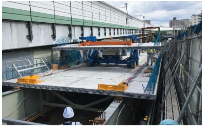
写真 2.1 平板型 UFC 床版架設状況（阪神高速道路 玉出入路橋）
