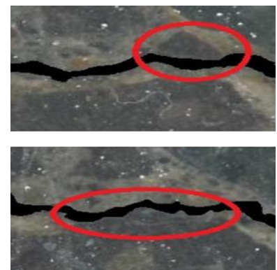
図-2 骨材に沿って生じたひび割れ
