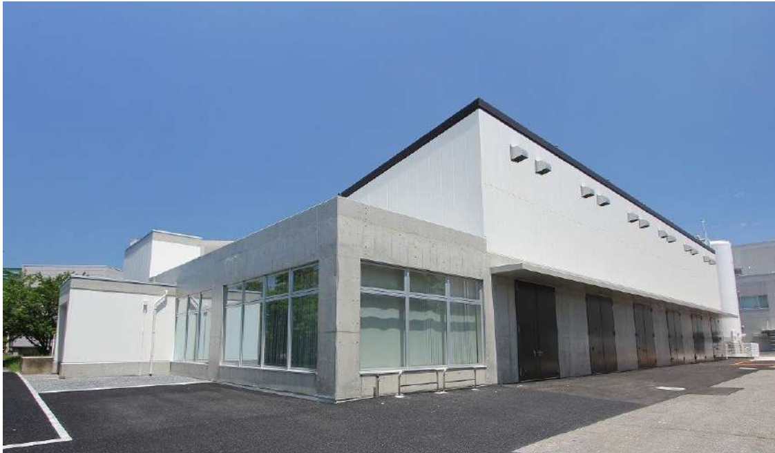
水素防爆実験室(6室), 液化水素貯槽(24,000 L)
