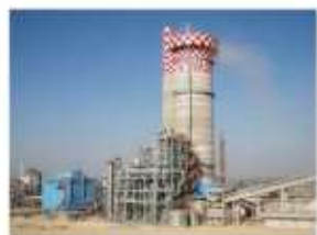
肥料プラント (水素大量製造)
