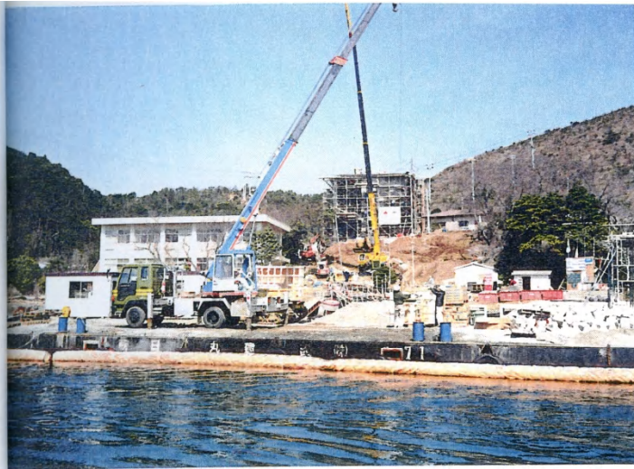
海側から見た工事中の実験所
