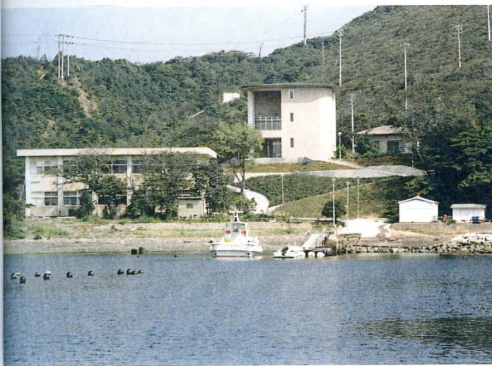
海側から見た竣工後の実験所
