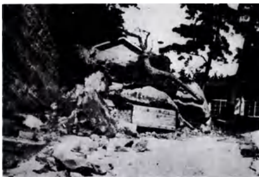
船着き場へ通じる道脇の崖崩れ
