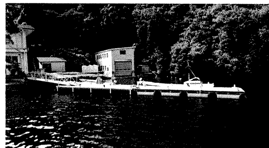
図9 増設後の浮棧橋
