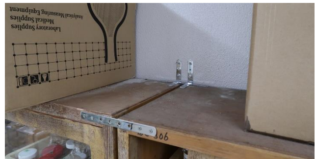
図2 標本棚と壁の固定
