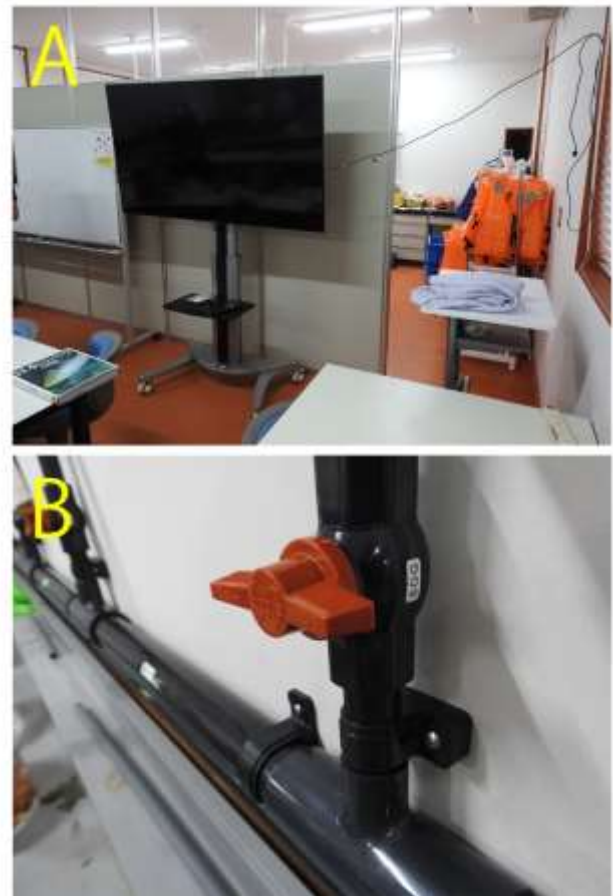
図 2.採集作業棟内部。 A：取り外してできた空間， B：固いバルブ
