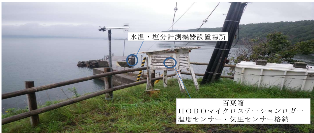
気象観測機器設置場所
