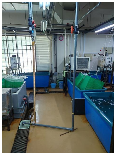
図4 排水管設置後
