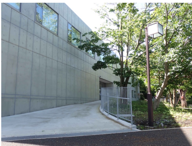
図 1. 教育棟（正面玄関側から）
