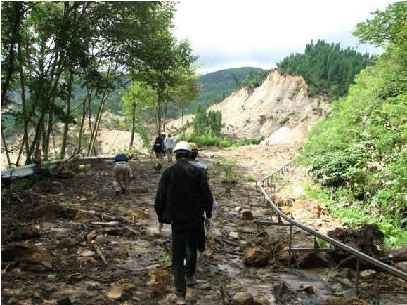
2008年岩手宮城内陸地震による胆沢ダムの崩壊
